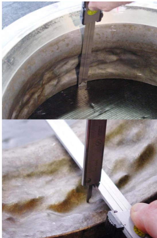
Figura 06: corrosión por baja temperatura de la pieza de fondo (tipo RTA tras 28.420 horas)
