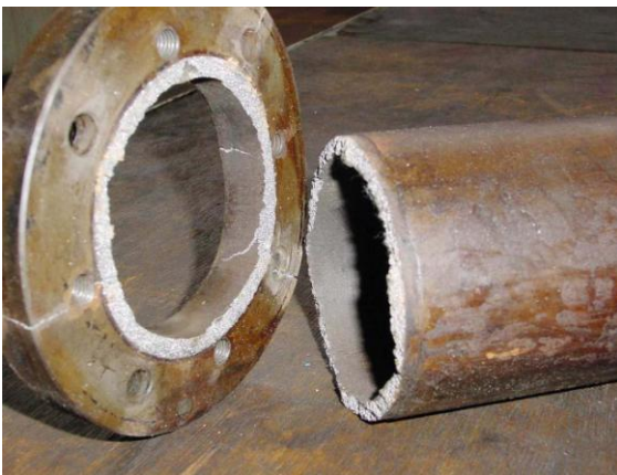
Figura 04a: rotura de la guía de válvula durante el desmontaje del vástago de válvula.
